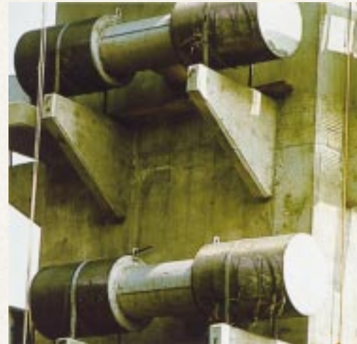
Instalación en Alto
